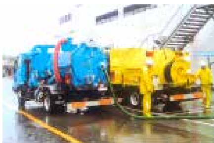
下水管の清掃(排水管洗浄)
