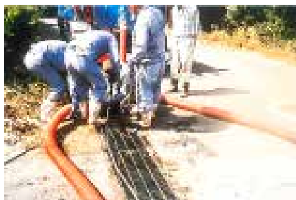
排水溝の清掃
