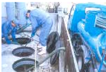
浄化槽の清掃
