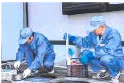
浄化槽の保守点検 維持管理
