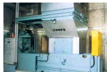
各種施設のオーバーホール全般
