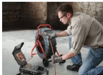
下水管の内部を調査する TVカメラ調査業務
