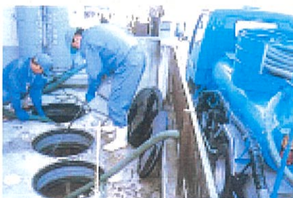
浄化槽の清掃
