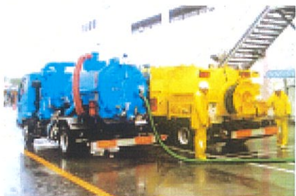
下水管の清掃(排水管洗浄)
