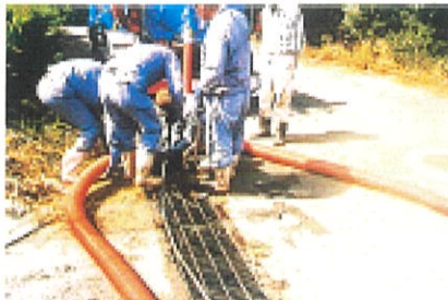
排水溝の清掃
